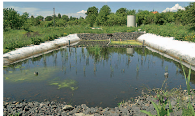
Praktická aplikace vědeckých poznatků: kořenová čistírna vybudovaná v rámci projektu Technologické agentury ČR
